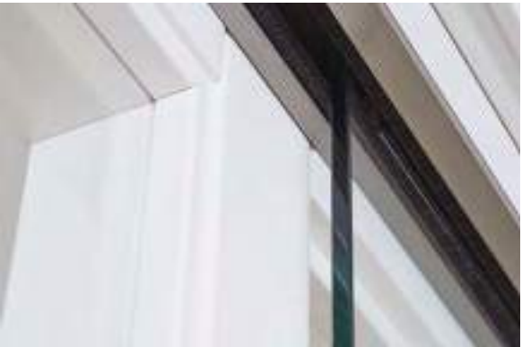
Befestigung einer Ganzglastür im Schiebetürbeschlag LINE
