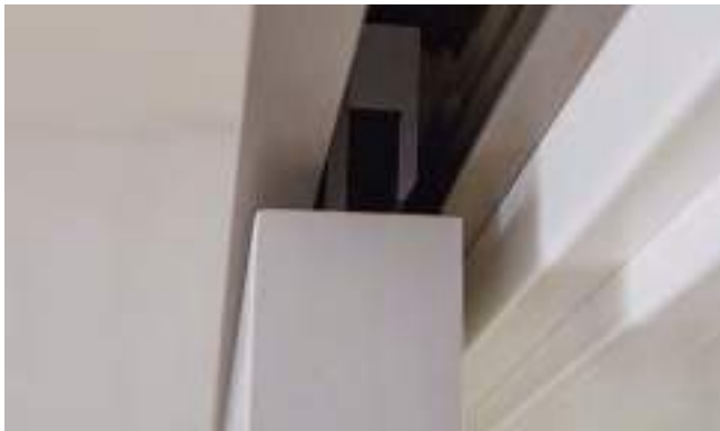
Befestigung einer Holztür im Schiebetürbeschlag LINE
